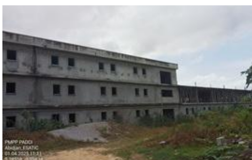
Vue du site de l'ESATIC à Abidjan
