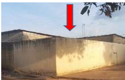
Vue d'un site GREEN à Bouaké qui a été démonté
