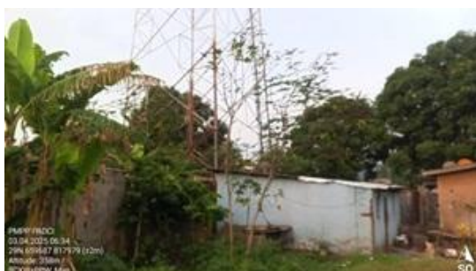
Vue d'un site de GREEN à Man
