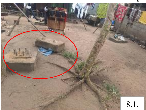
Socle du pylône non-démantelé dans une maison par ex-opérateur COMIUM à N'Zikro
